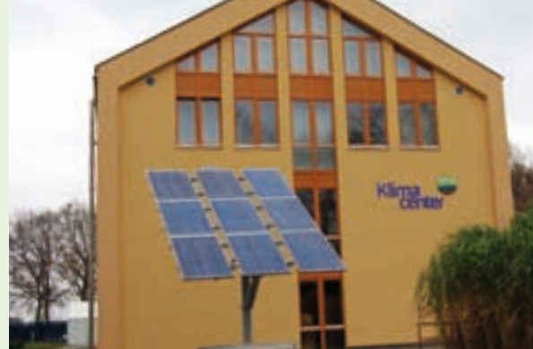
Photovoltaik-Anlage des Klimacenters
