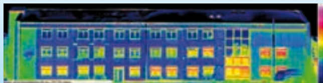
Wärmeaufnahme des Klimacenter
