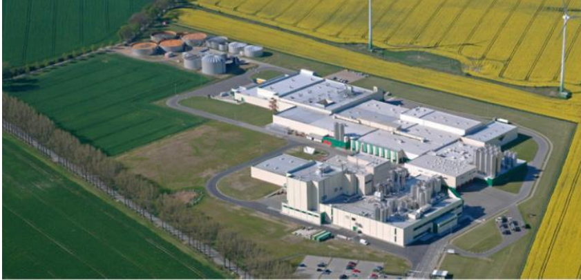
DMK Altentreptow mit anaerober Abwasserbehandlung
