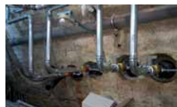
Die Wärmeleitungen waren in der historischen Bausubstanz nur mit erheblichem Aufwand zu verlegen.
